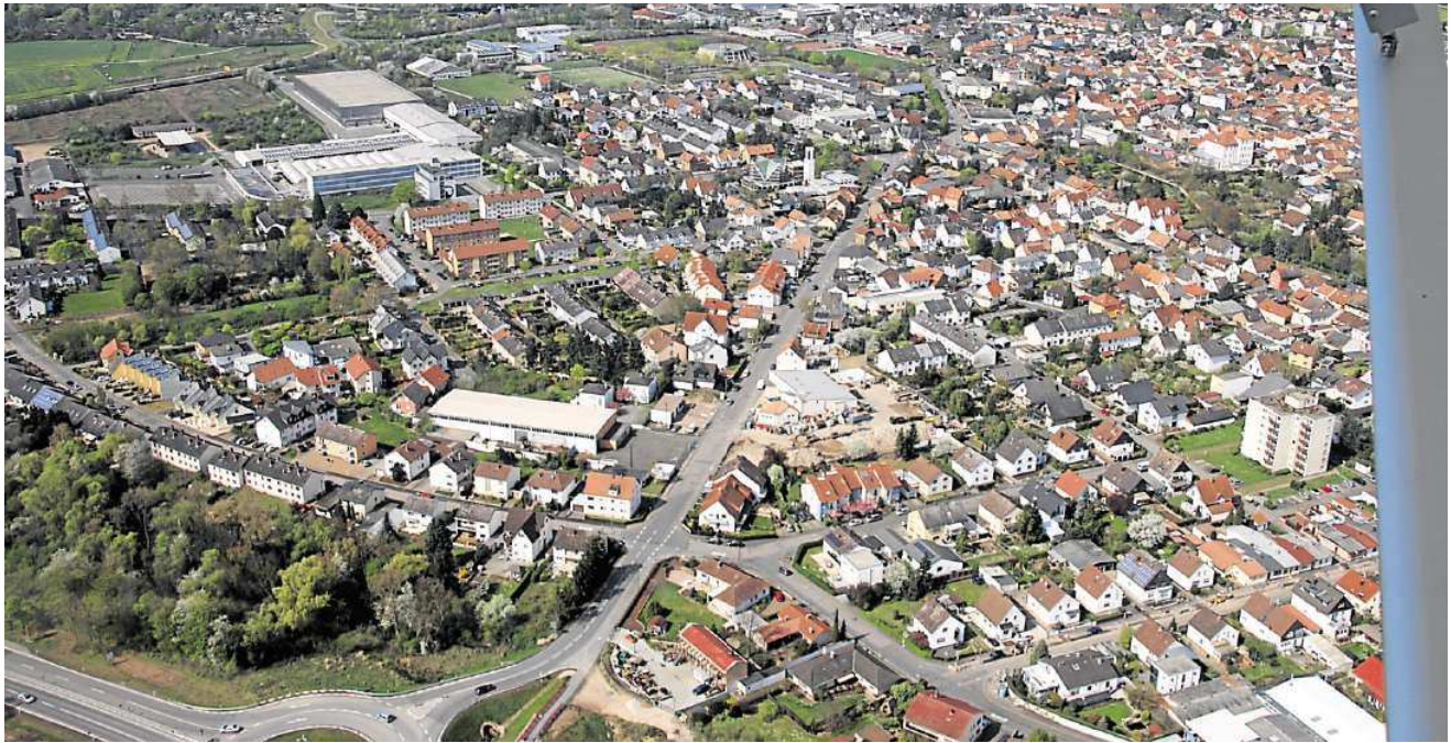
Die Meinungen gehen auseinander, ob mit dem Bau des Turbo-Kreisels auf der Stadtumgehung (unten links) der Verkehr in den Stadtteil Büdesheim über die Dromersheimer Chaussee (Mitte) eher zu oder abgenommen hat. Foto: Kurt Honrath
