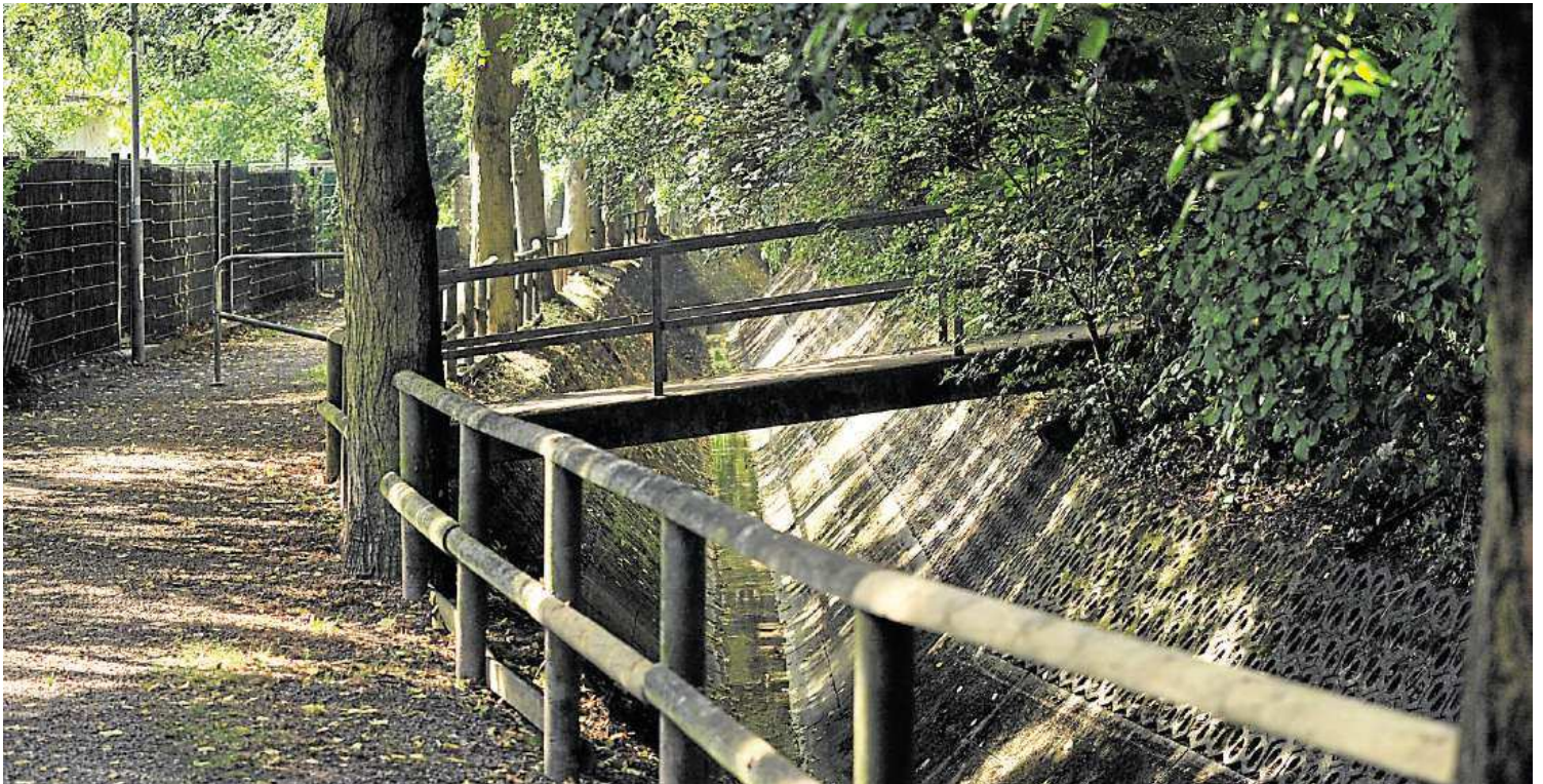
Noch fließt der Entenbach in einem gemauerten Korsett seiner Wege. Nach der Renaturierung soll das Gewässer wieder viel Raum zur Entfaltung bekommen. Foto: Thomas Schmidt
